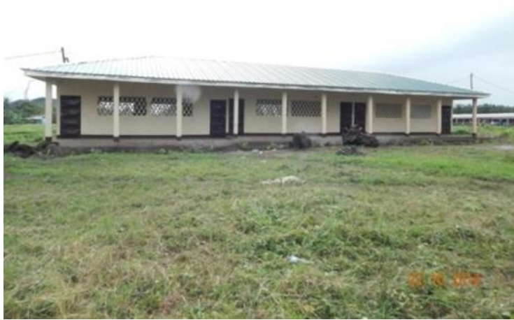
Neubau in Tiko
